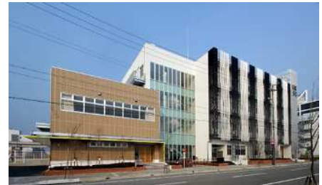
【神戸ハイブリッドビジネスセンター全景】
